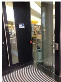
Blick von der 1. Haupteingangstür auf die baugleich folgende Tür
